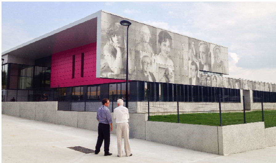
Рис. 1. Высшая средняя школа Crevin, Франция, 2014. На фасаде — графический бетон
